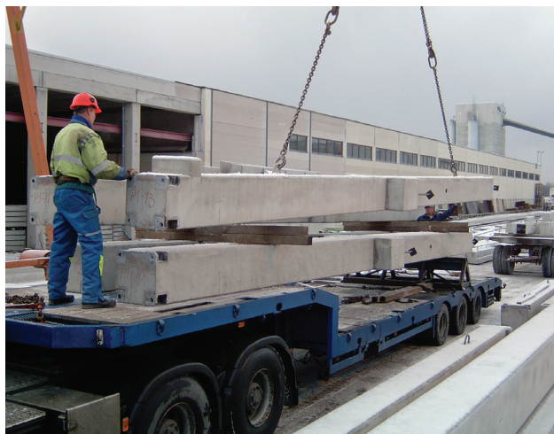
Pilarelementtien lastaus menossa. Takana pokatun lavan vaatimat aluspukit.
