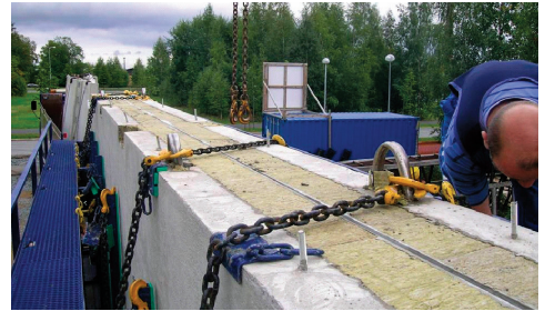
Seinäelementtikuorma sidotaan nostolenkkien läpi ja elementtien kulmat suojataan ketjulta.
