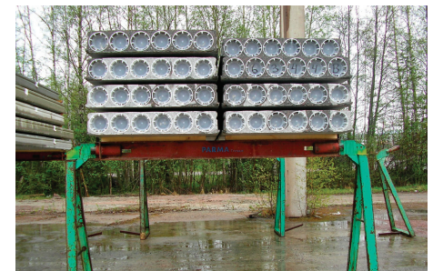
Ontelolaatat valmiskuormapukeilla. Pukkien jalkojen alla tulee olla riittävän kantava maapohja. Tarvittaessa käytetään aluslevyjä.
