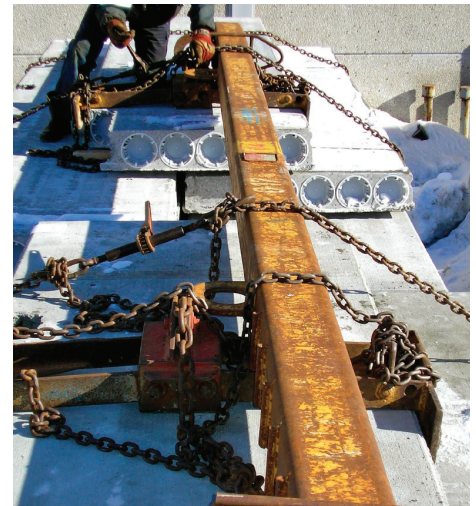
Nostopuomi kulkee kuorman päälle sidottuna työmaalle.
