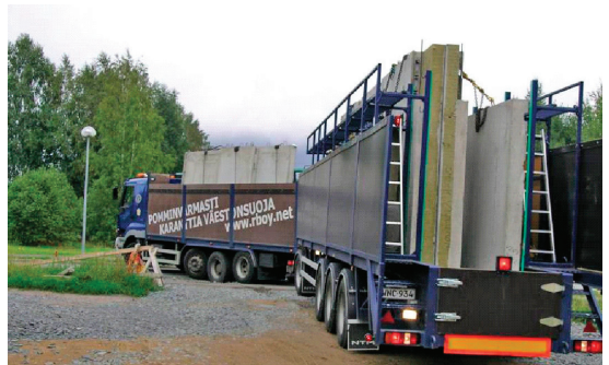
Ajoväylien työmaalla tulee olla riittävän kantavia ja leveitä.
